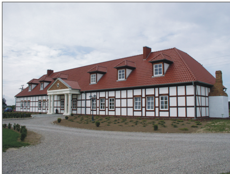
B. Rzyszczewo. „Dworek Polski” – zajazd przy drodze Sławno–Koszalin. Fot. E. Florek, 9.08.2006
